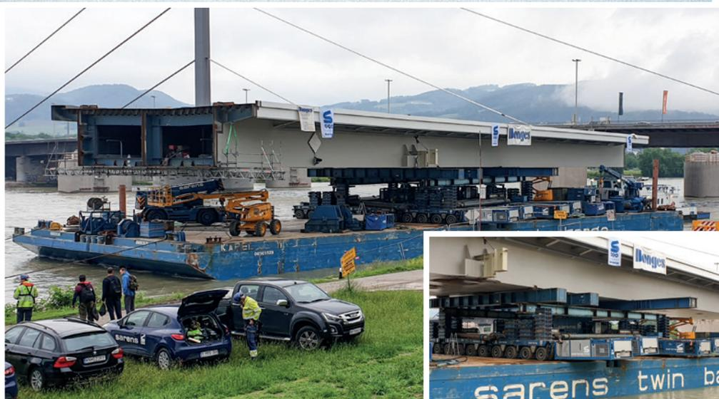
Das Einschiffen der Bauphase II mit Detailaufnahme der Kletterhydraulik. Fotos: SCH/A. Prammer.
