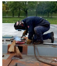
Die Einzelteile werden in Darmstadt gefertigt, nach Linz transportiert und hier am Vormontageplatz zu einem Stück zusammengebaut.
