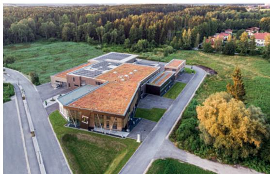
Klimaneutral. Die Zentrale in Bürmoos besticht durch eine Photovoltaikanlage, E-Tankstellen, Dachbegrünung und Sole-/Wasser-Wärmepumpen.
